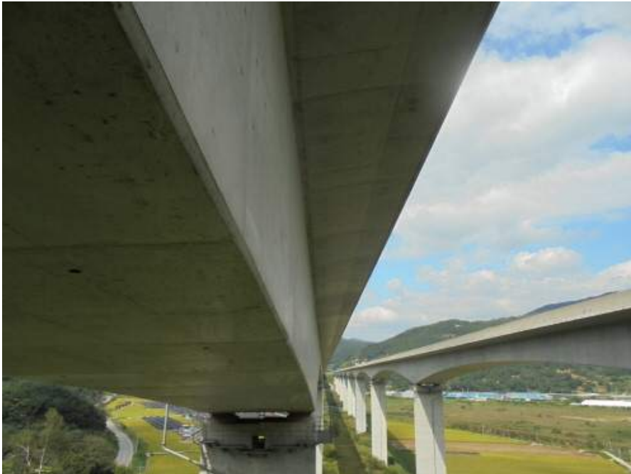
거더 외부 전경
