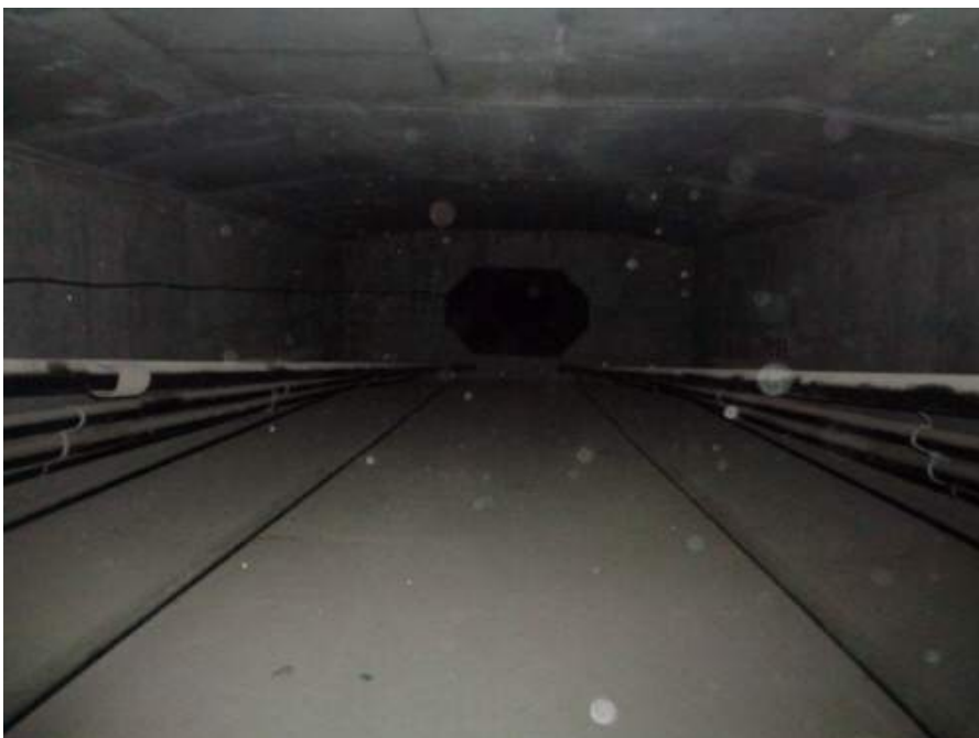
거더 내부 전경
